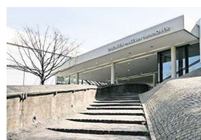
Die Kosten für Brandschutzsanie rung kletterten im Sprengel-Museum von 4 auf 11 Millionen Euro.
