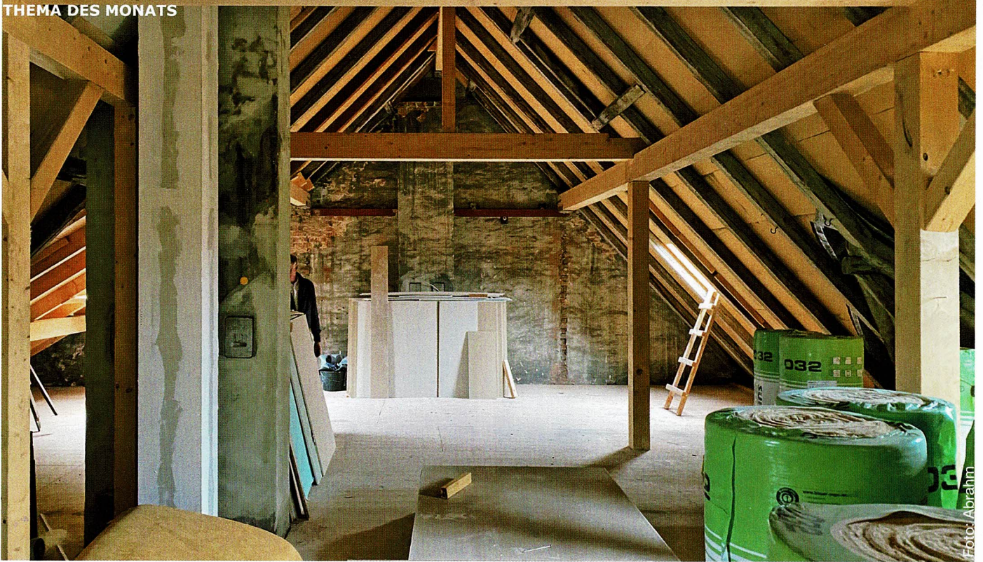
Auf diesem 200 Quadratmeter großen Dachboden eines Mehrfamilienhauses in der List sollen kleine, bezahlbare Studentenappartements entstehen – doch das Vorhaben scheitert bisher an der Stadt.
