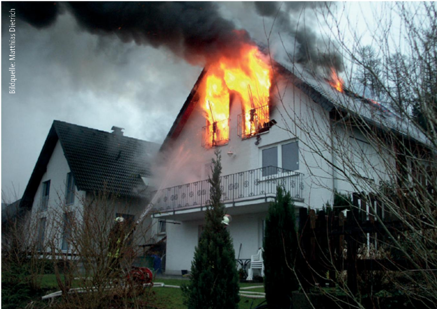
Abb. 3: Die Annahme, dass alle Personen am brennenden Fenster verharren, obwohl ein erster Rettungsweg noch benutzbar ist, lässt sich weder aus dem Bauordnungsrecht, den natürlichen menschlichen Instinkten, noch mit dem geschulten Verhalten im Brandfall (Arbeitsstättenrecht) erklären.
