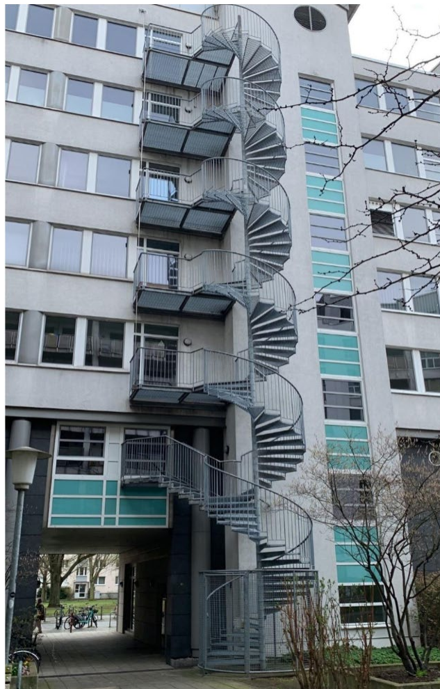
Abbildung 3.6-2: Beispielhafte Ausführung einer Spindeltreppe
